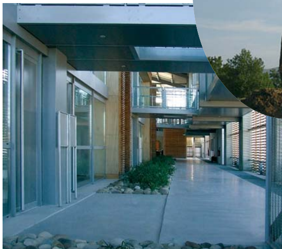
le centre tertiaire de Lagnes (intérieur)
