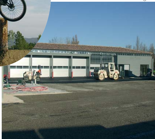
le centre technique de Robion
