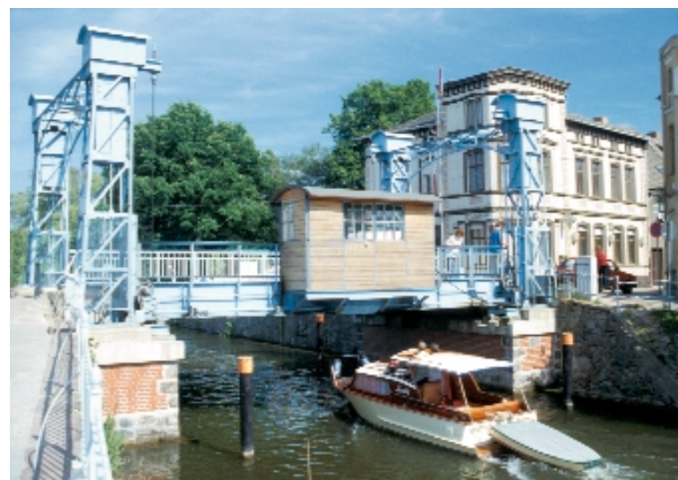
Fluss Elde, Hubbrücke in Plau am See
